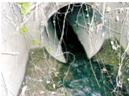
Tą rurą spływają ścieki do Nysy Kłodzkiej, fot. LJ
