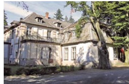
Z inicjatywy księcia Friedricha von Saurma-Sterzendorf w latach 1917-1919 gruntownie przebudowano pałac nadając mu barokowo-klasycystyczny wygląd
