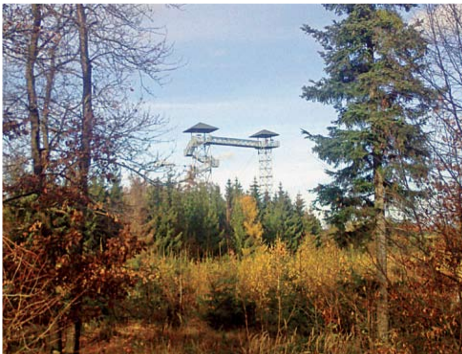
Wieża widokowa na Wzgórzu Granicznym
