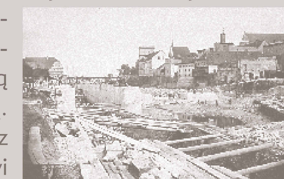
Budowa śluzy na kanale Młynówka koniec XIX w. Zbiory MŚO
