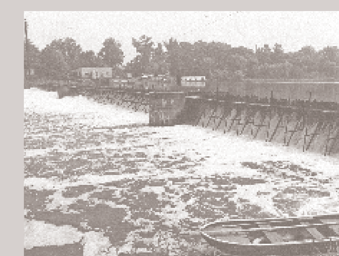
Jaz iglicowy na Odrze 1981, fot. M. Maruszak, zbiory WUOZ w Opolu
