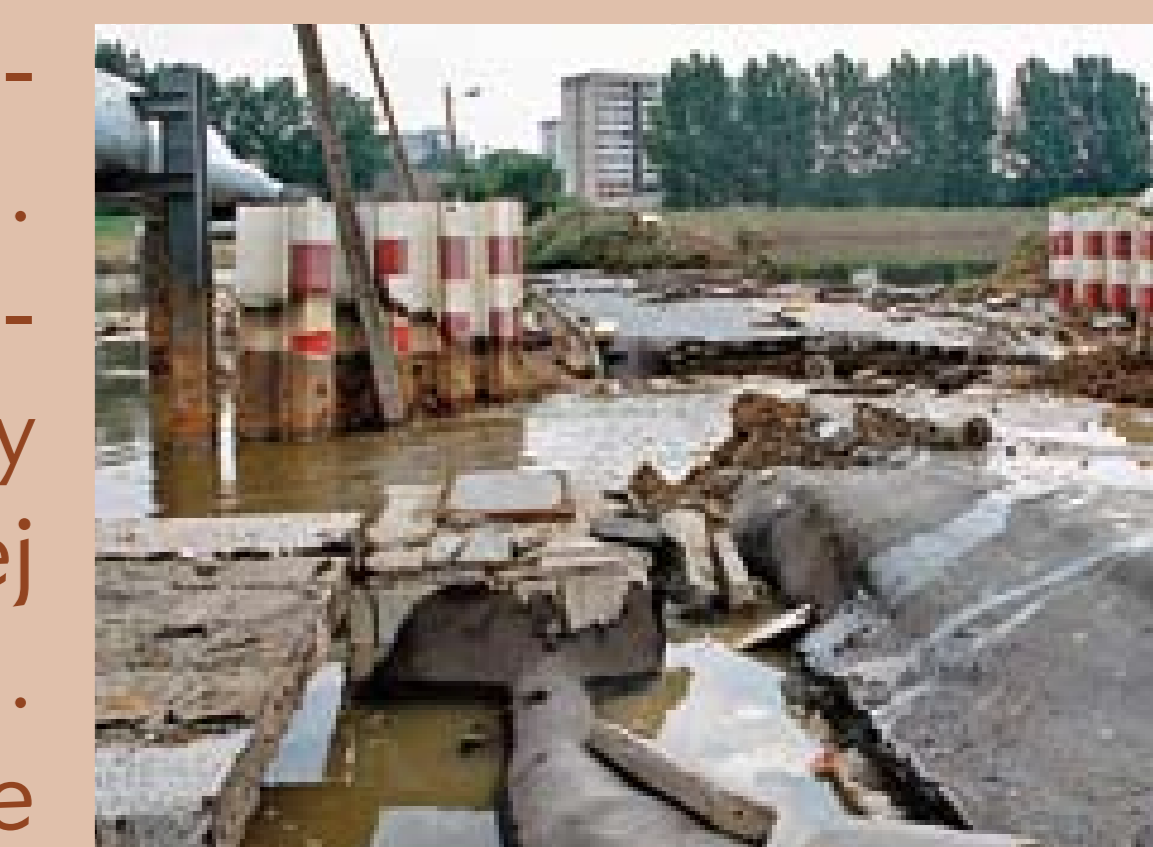
Zniszczenia 1997 r., fot. J. Stemplewski
