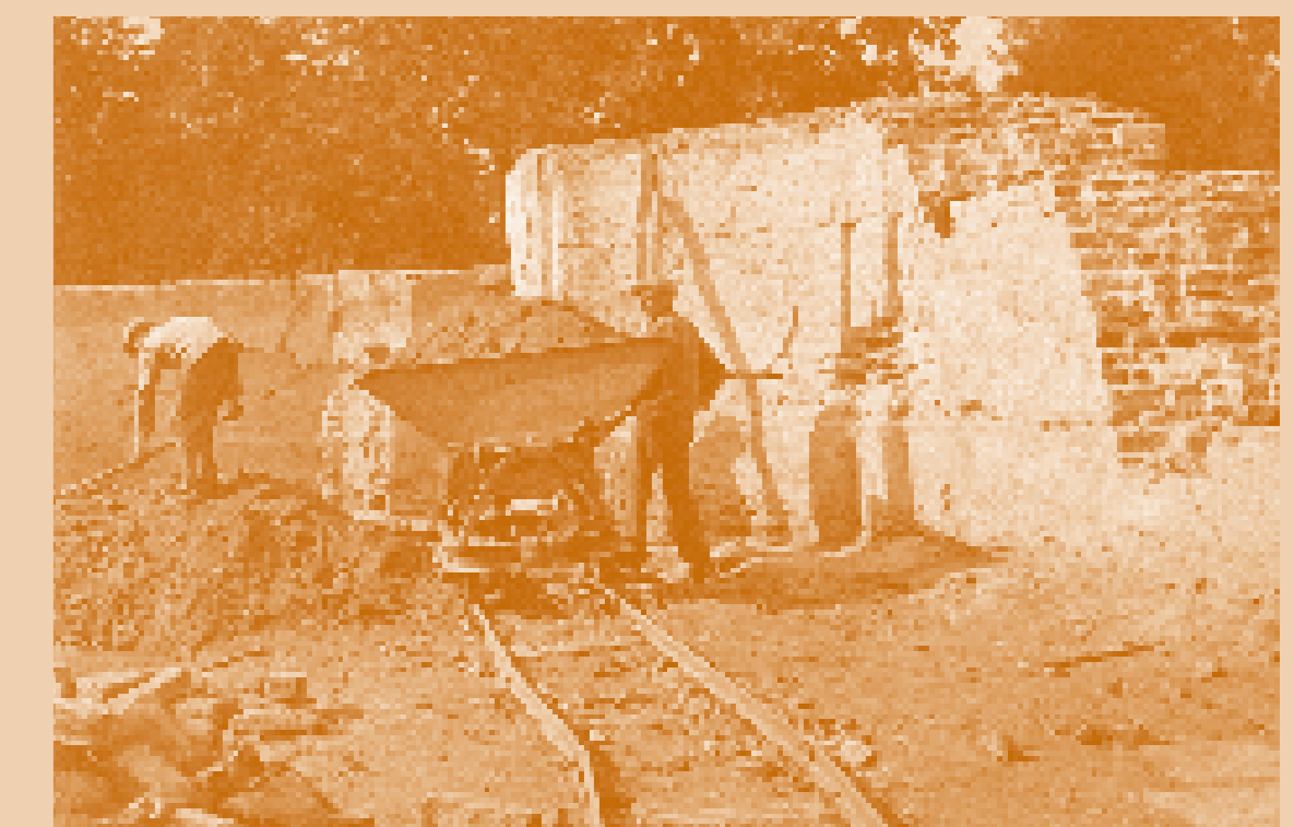
Rozbiórka murów miejskich, zbiory WUOZ w Opolu
