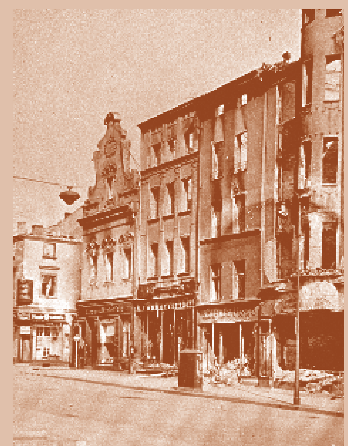
Zniszczona południowa strona Rynku, 1946 r. Zbiory MŚO
